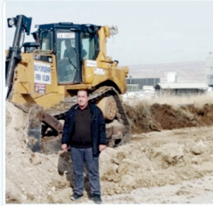
HASANOĞLAN SANAYİ BÖLGESİ Yol genişletme çalışması
