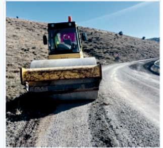
TATLICA VE KURTULUŞ İmar yolu dolgu çalışması
